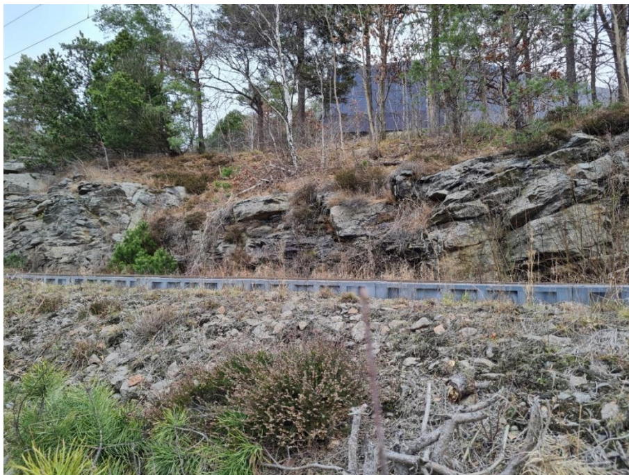
Figur 6. Mittendelen av skärningen. Lägsta delen med något skivigare karaktär.
