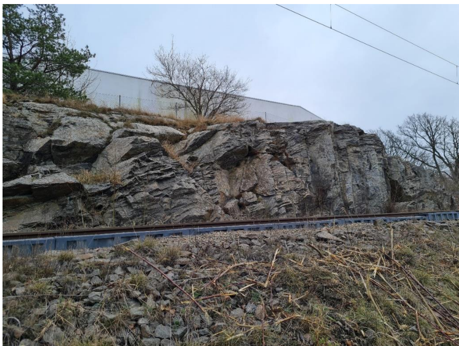
Figur 7. Södra delen av skärningen. Storblockig struktur med delvis synliga borrhpor.
