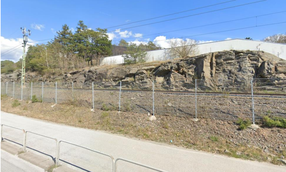
Figur 6 visar Bohusbanan samt bergsränning öster om järnvägen där GC-väg är tänkt att anläggas. Vy mot öster. © Google, 2023.
