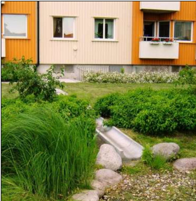
Figur 10. Exempel på ränna för avledning av takvatten
