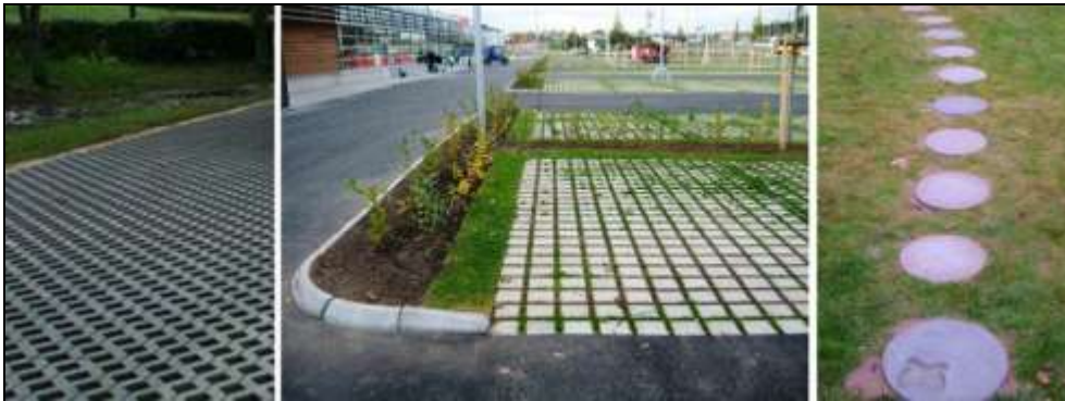
Figur 7. Ytor med hålsten av betong samt gångstig med gräs och gångplattor
