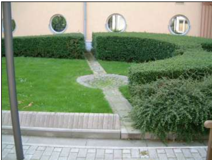
Figur 9. Exempel på ränna för avledning av takvatten
