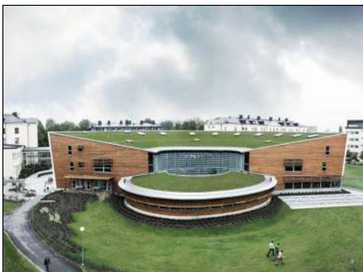
Figur 6. Exempel på byggnad med grönt tak (Källa: VegTech)
